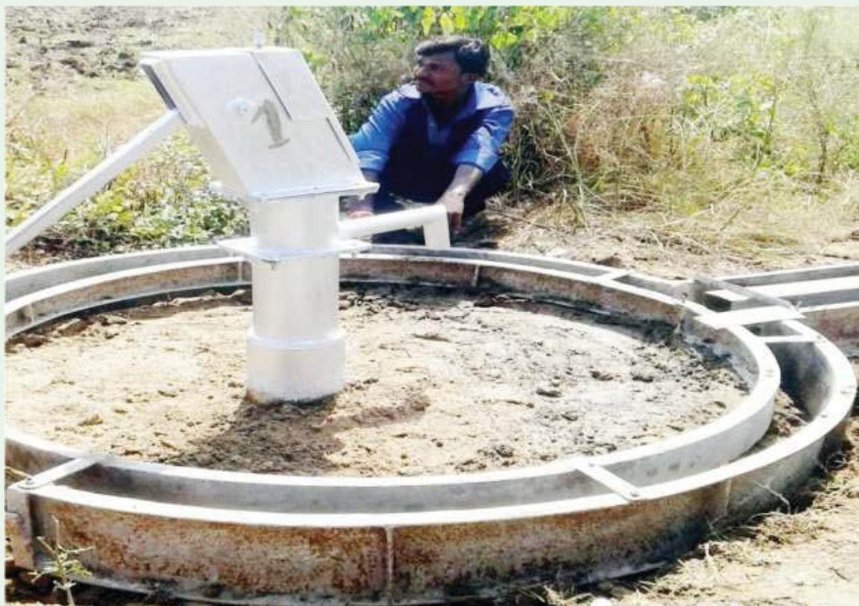
ग्राम तजपुरा, विकासखण्ड टिमरनी, जिला हरदा में प्लेटफार्म का निर्माण
