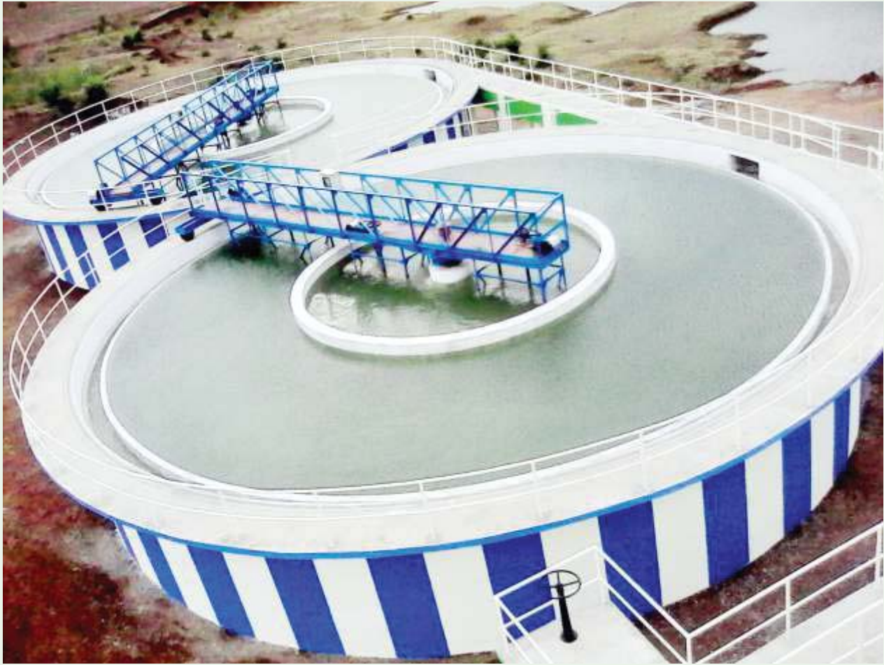
खुरई नगर आर्बधन जल प्रदाय योजना (डिपॉजिट वर्क), में निर्मित जल शोधन सयंत्र, क्षमता 12.8 एम.एल.डी, फ्लाकुलेटर
