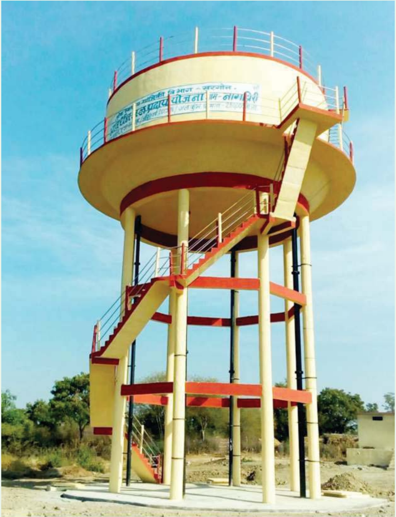
नलजल योजनाओं के माध्यम से बसाहटों का आच्छादन। ग्राम नागझिरी, विकासखण्ड गोगांवा, जिला खरगोन में निर्मित उच्च स्तरीय टंकी, क्षमता 280 कि.ली., ऊँचाई 12 मीटर
