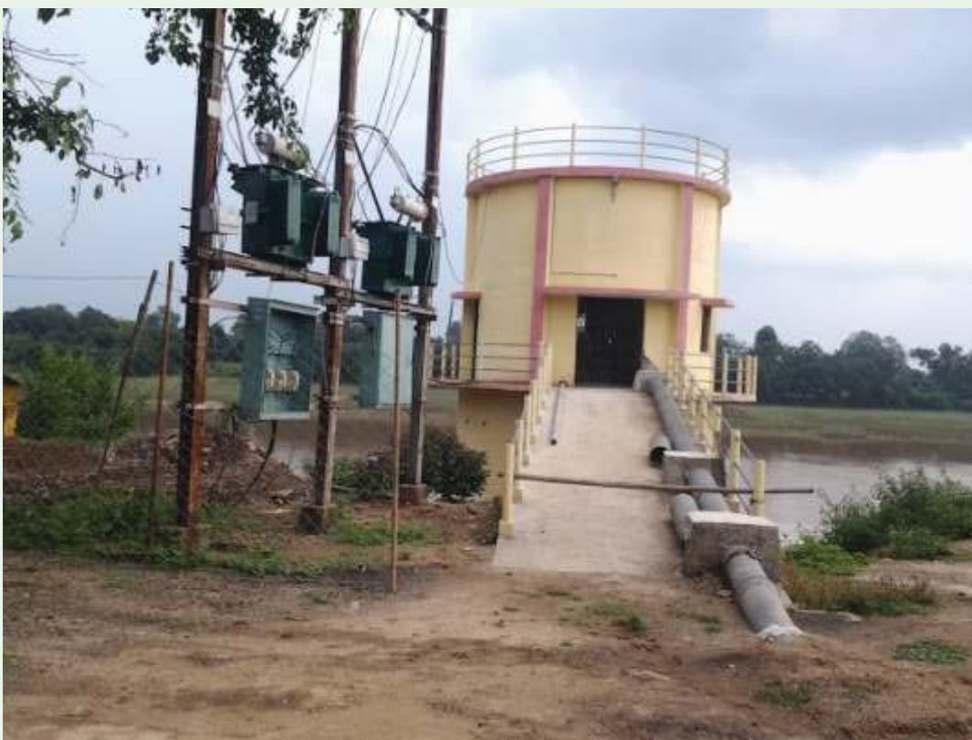
गुणवत्ता प्रभावित बसाहटों की समूह नल जल प्रदाय योजना, नर्मदा नदी पर आर.सी.सी. इंटेकवेल सह पम्प हाउस का निर्माण कार्य, व्यास 6.0 मी. ऊँचाई 18 मी. ग्राम एवं पंचायत बड़ी खैरी, विकासखण्ड-मण्डला, जिला मण्डला
